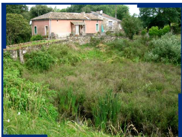
11 : "Le Moulin de Berthouin" : la maison est en zone inondable
