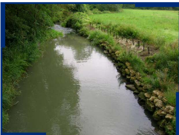
17 : "Le Gué de Landin" : 30 m d'enrochement et de protection végétale sur ce secteur
